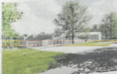
Le projet de crématorium de Saint-Laurent-de-Mure, dans le Rhône. Photo: Atelier Roland Prieum Architecte
